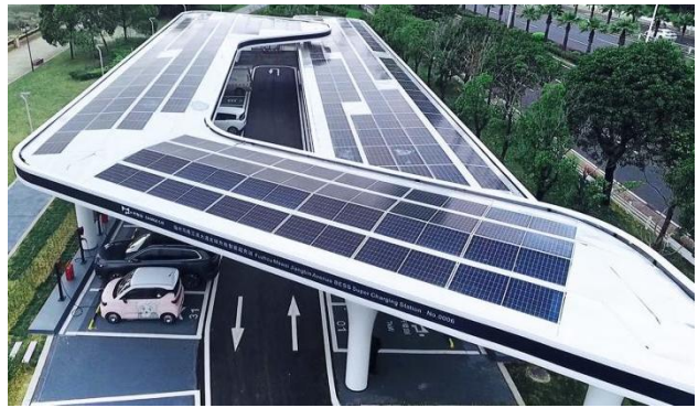
光储充一体式充电站
