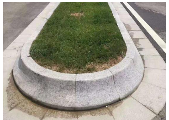
圆弧侧石示意图
