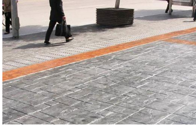
现浇（压膜）混凝土
